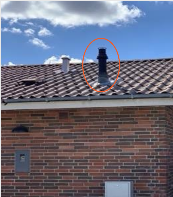
Omkostning til demontering af lodret gasaftræk.
