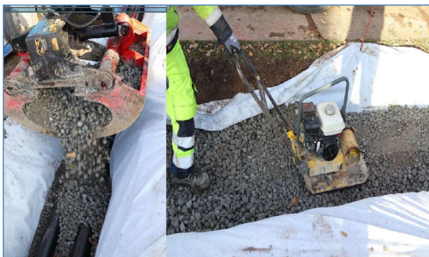
Affaldsglas-produktet Durapor testes som foring omkring fjernvarmerør på en 18 meter lang strækning i Næstved. Foto: Dansk Celleglas A/S
